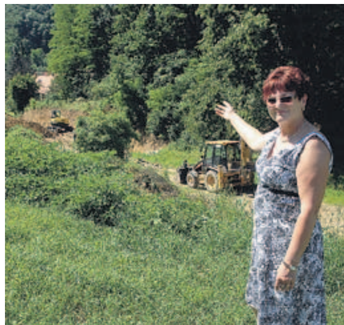
Ugyancsak Báticaapátiban a belterületi vízrendezést is a Közúti Építő és Szolgáltató Kft. végzi. A több mint 100 millió forint értékű beruházás a végéhez közeledett, jövő héten lesz a műszaki átadása. Darabos Józsefné, a község polgármestere mutatja az érintett szakasz egy részét
